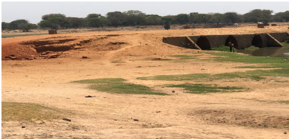
Photos 3 : Sources : Afd, Photos de terrain 2023, Fleuve Mandoul au PK1°750 et ses voies d'accès
